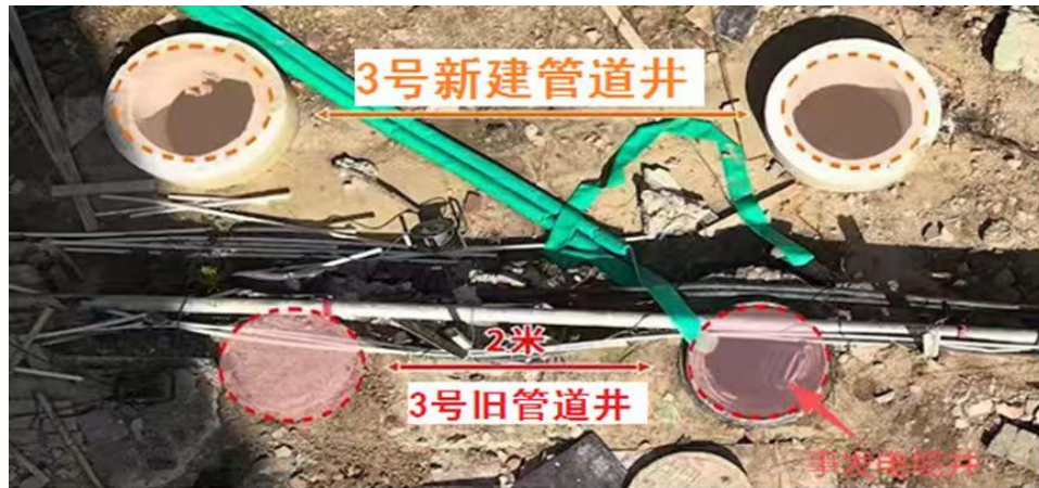
图 1 事发管道井位置
